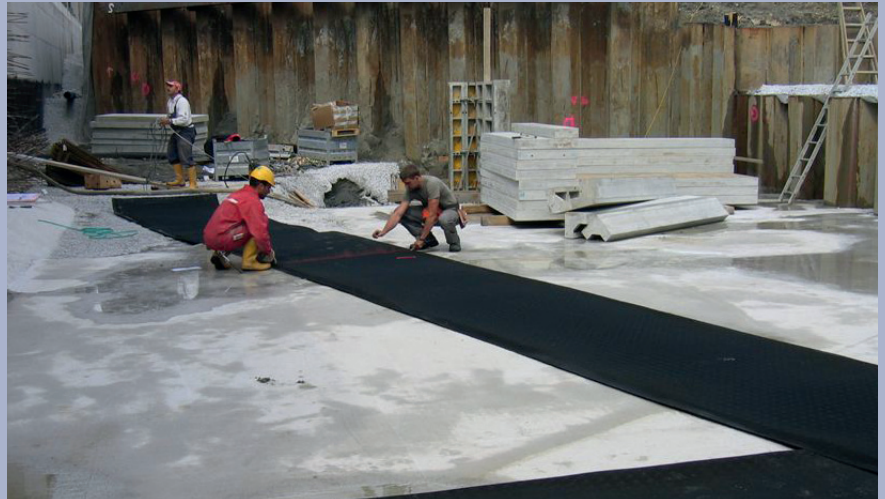
Bild 1: Zuschneiden der Matte
