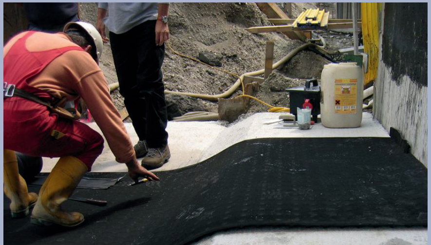
Bild 2: Verlegen der Matte
